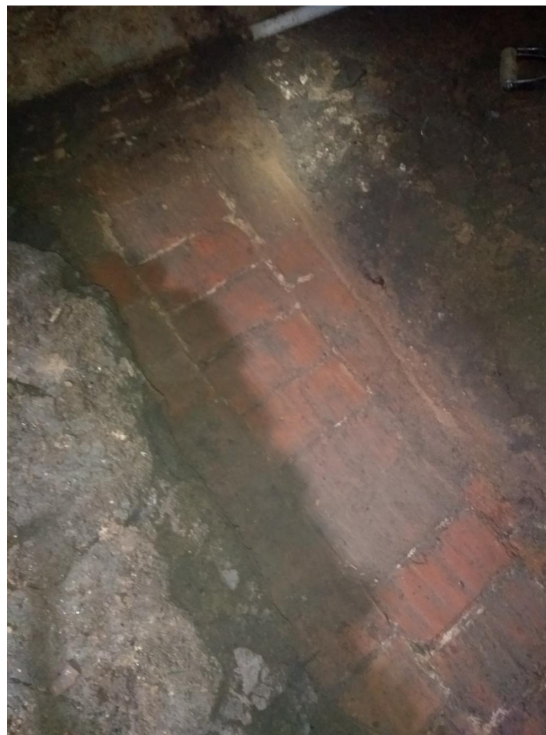
Foto 113.18.6, vista del paviment de la claveguera UE 09.
