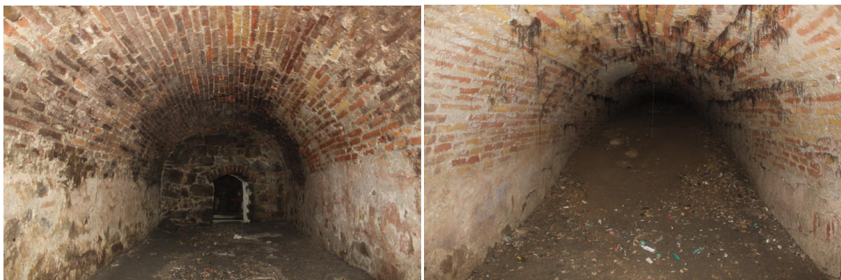
Foto 113.18.4 i 113.18.5, vistes interiors de la Claveguera.
