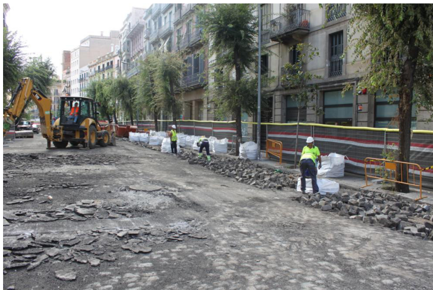
Foto 113.18.1, vista de l'extracció de l'asfalt (UE 01) i del paviment de llambordes (UE 02).
